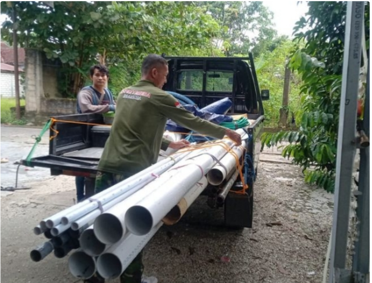
Satgas TMMMD ke-113 Kodim 1006/Banjar Angkut Materiil pembuatan Sumur Bor
