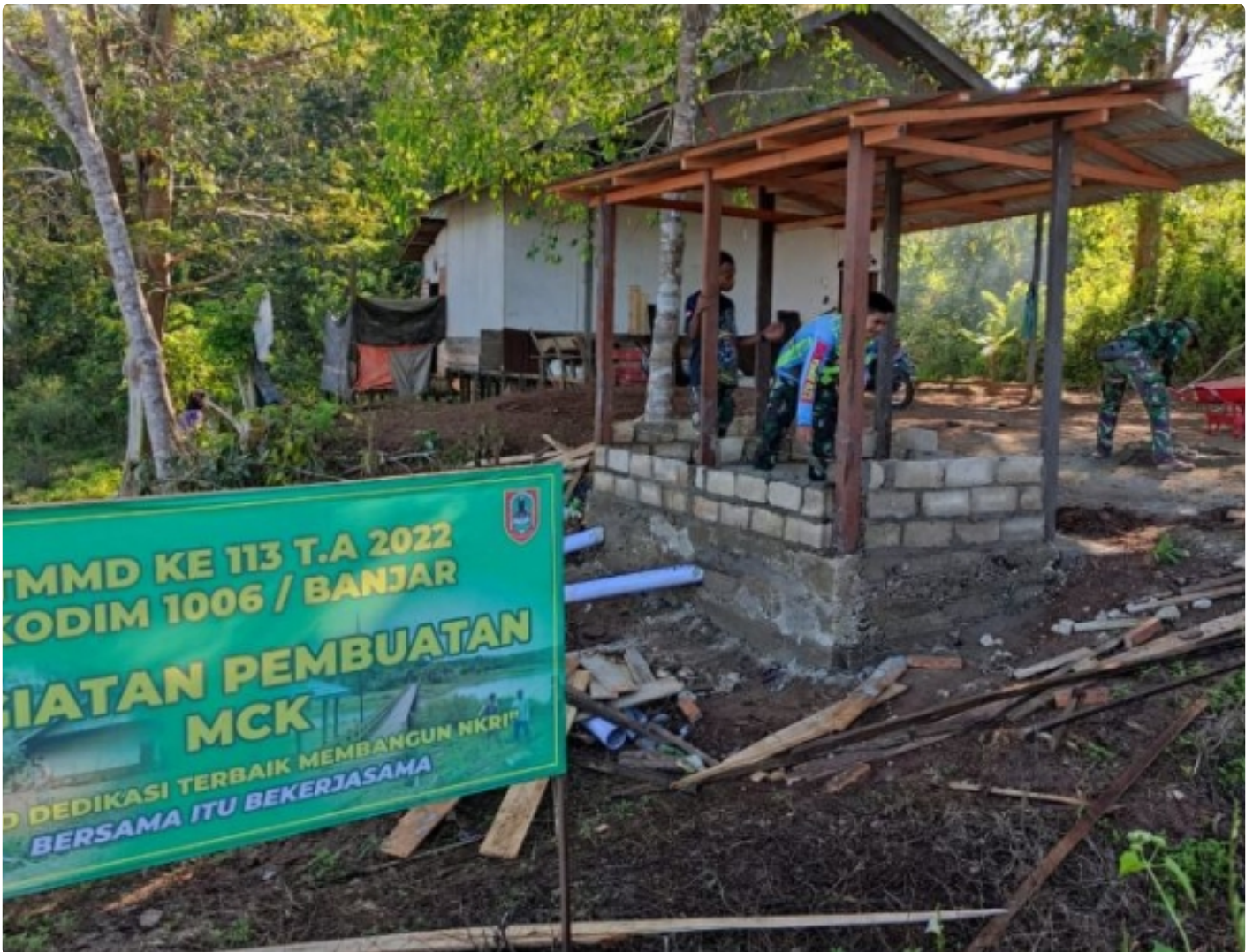
Sasaran WC Terus dikerjakan Satgas TMMMD ke-113 Kodim 1006/Banjar
