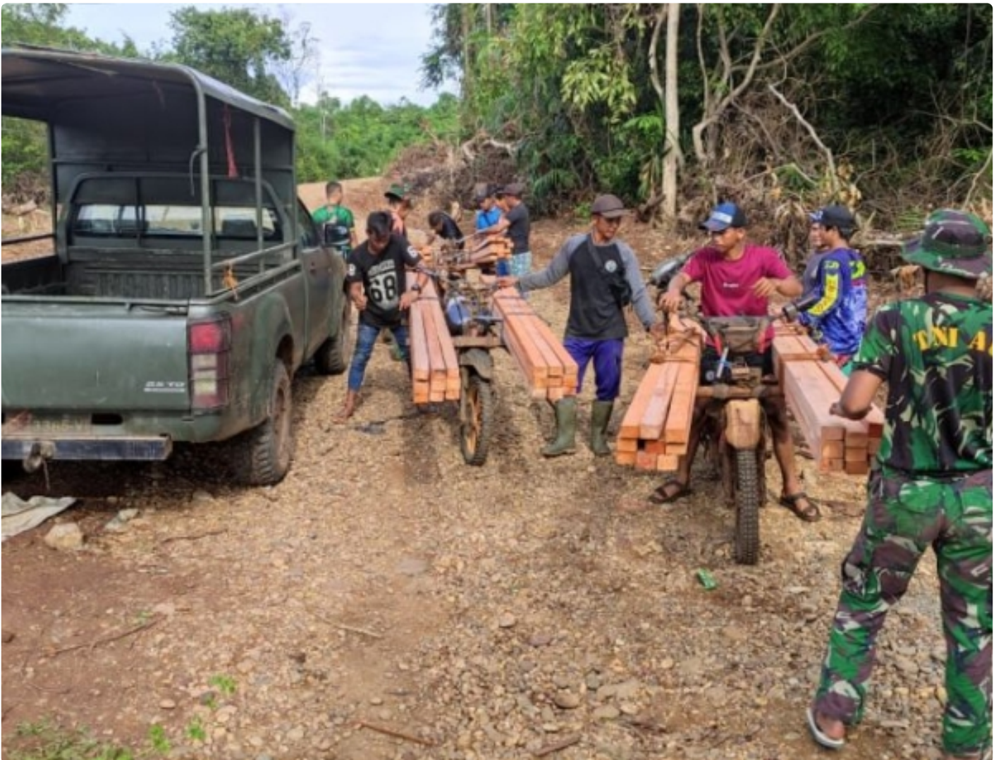
Warga Bantu Bawa Balok Kayu Untuk Jembatan
