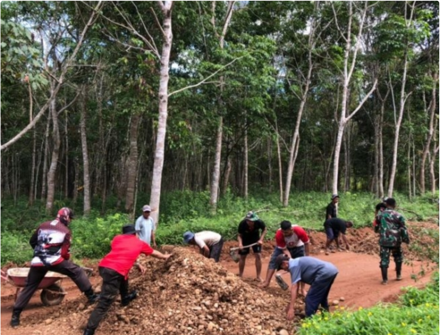
Anggota Satgas TMMD ke-113 Kodim 1006/Banjar dan Warga Gotong Royong Uruk Jalan
