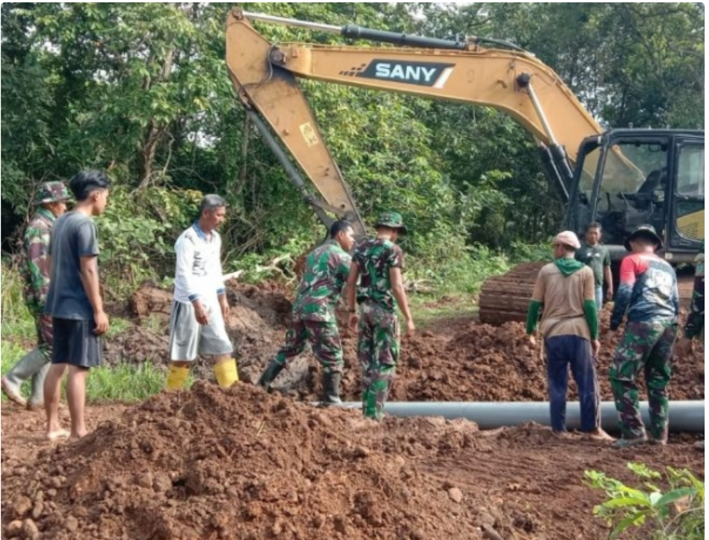
Pemasangan Pipa Saluran Air
